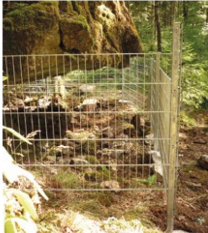
49. Stabgitterzaun am Schwarzen Mann. Die erste und weniger gelungene Maßnahme im Projekt, da es sich eher um eine Umzäunung als eine Vergitterung handelt. Sie hält den Besucher vom Denkmal fern und steht optisch im Vordergrund. Eine bessere Variante wurde kurz darauf für den Wanderweg in Dasburg entwickelt. Je nach Höhe liegt der Preis bei 150 €/lfm. Foto: BUND RLP
