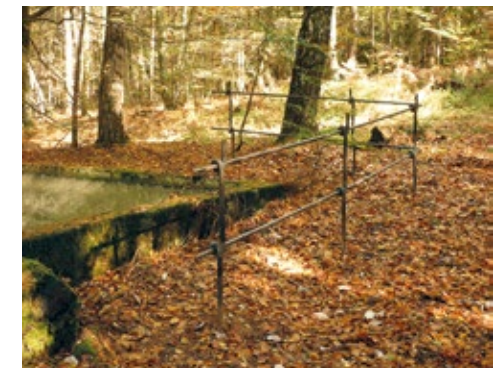
16. Durch ein Gelände entschärfte Absturzkante. Der Preis variiert zwischen 200 und 400 €/lfm, je nach Linienführung (gerade oder abgerundet). Durchführung: Metallwerkstätte Schary, Foto: BUND RLP
