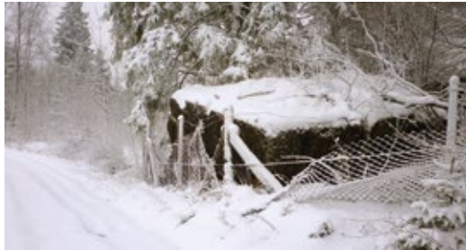
22. Durch natürliche Ereignisse und Vandalismus zerstörte Umzäunung, die nun selbst zu einer Gefahr geworden ist. Foto: BUND RLP
