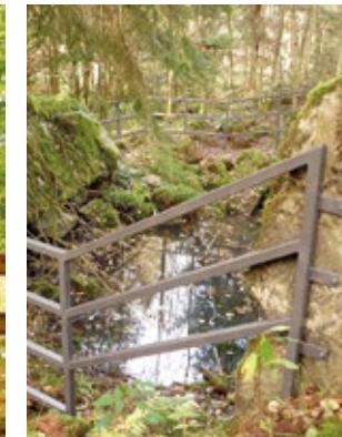
30. Zaun aus anthrazitfarbenem Quadratrohr am Schwarzen Mann, grob an die Form des ehemaligen Bunkers angepasst. Die Kosten liegen je nach Aufwand bei etwa 150 €/l/m, die Haltbarkeit ist jedoch größer (vermutlich 30 Jahre und mehr). Durchführung: MARKUS THIES, WERNER BITZIGEO. Foto: BUND RLP
