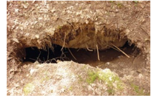
37. In der Vergangenheit übererdete Ruine mit gefährlichen Einspülungsspalten. Foto: BUND RLP
