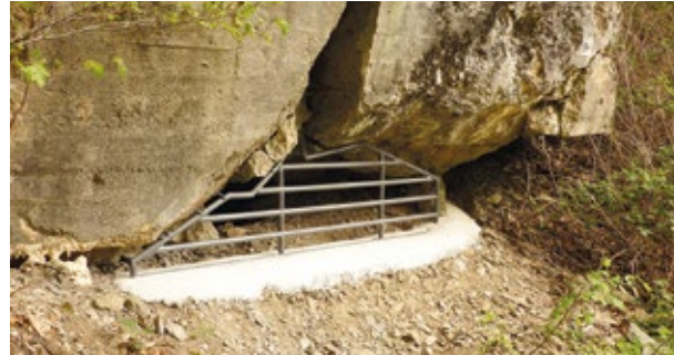
50. Ein formangepasstes und innerhalb der Öffnung eingesetztes Gitter wie hier wirkt weniger dominant und die Ruine steht weiterhin im Vordergrund. Die Kosten richten sich stark nach der Größe und Form (ca. 500-1000 €/m 2 ). Durchführung: MARKUS THIES. Foto: BUND RLP
