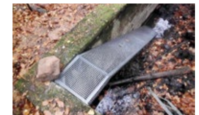
68. Aufstiegsrampe für Amphibien aus einem Wasserbecken. Die Kosten belaufen sich auf ca. 500 €. Durchführung und Foto: Metallwerkstätten Schary
