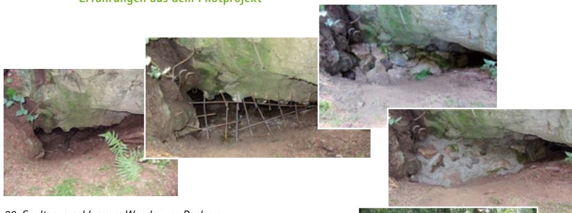
39. Spaltenverschluss am Wanderweg Dasburg. Zuerst wurden Moniereisen in die Spalte eingelassen. Das so entstandene Gitter wurde mit Betonbrocken überdeckt und mit Beton verfügt. Dieser Schritt ist überflüssig, wenn die vorhandenen Betonbrocken die Spalte ausreichend abdecken. Anschließend wird wieder Erde aufgeschüttet und einige Wochen später ist die ehemalige Einspülungsspalte nicht mehr zu sehen. Die Baukosten belaufen sich, je nach Aufwand, auf um die 1000 € pro Ruine. Durchführung und Fotos: MARKUS THIES
