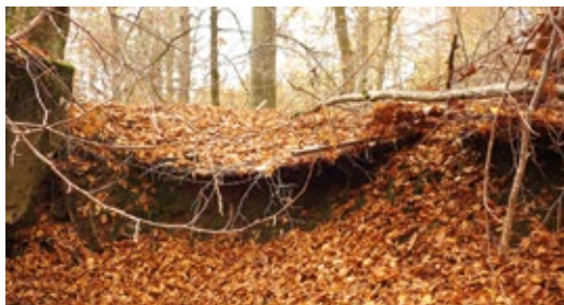
23. Ein umgedrückter Zaun im Herbst. Von unten erkennt man die Gefahr, von oben nicht! Die Absturztiefe beträgt ca. 150 cm. Inzwischen ist die Einzäunung erneuert worden, es ist aber nicht abzuschätzen, wie lange sie dieses Mal halten wird. Foto: BUND RLP
