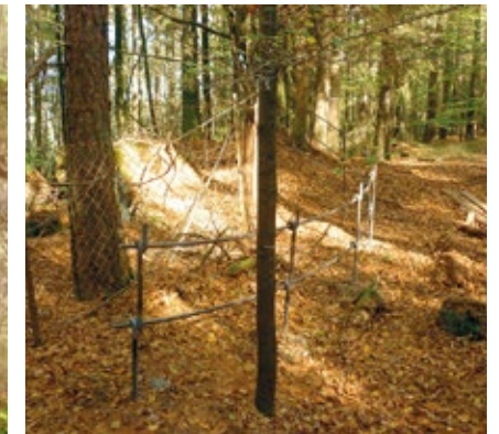
31. Zaun aus Rundstahl mit unbehandelter Oberfläche, genau angepasst an die Form des ehemaligen Bunkers. Der Zaun passt farblich in die Umgebung und fällt kaum auf. Je nach Umfeld und Geradheit oder Rundung des Zauns betragen die Kosten zwischen 200 und 400 €/l/m, die Haltbarkeit liegt vermutlich bei weit über 30 Jahren und die technischen Möglichkeiten (Einbau von Rundungen) sind größer als beim Quadratrohr. Durchführung: Metallwerkstätte Schary. Foto: BUND RLP
