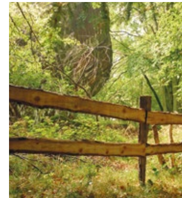
29. Holzzaun zur Besucherlenkung am Wanderweg in Dasburg. Der Zaun ist einfach überwindbar, signalisiert jedoch jedem, dass sich dahinter Gefahrenstellen verbergen. Das Material ist verhältnismäßig günstig (je nach Ausführung 30-80 €/l/m), aber nicht dauerhaft. Die vermutete Standzeit ohne größere Reparaturen beträgt 10-15 Jahre. Durchführung: Forstbetrieb Sebastian Rech. Foto: BUND RLP
