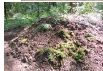
39. Spaltenverschluss am Wanderweg Dasburg. Zuerst wurden Moniereisen in die Spalte eingelassen. Das so entstandene Gitter wurde mit Betonbrocken überdeckt und mit Beton verfügt. Dieser Schritt ist überflüssig, wenn die vorhandenen Betonbrocken die Spalte ausreichend abdecken. Anschließend wird wieder Erde aufgeschüttet und einige Wochen später ist die ehemalige Einspülungsspalte nicht mehr zu sehen. Die Baukosten belaufen sich, je nach Aufwand, auf um die 1000 € pro Ruine. Durchführung und Fotos: MARKUS THIES
