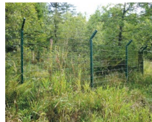
11. Übertriebene Verkehrssicherungsmaßnahme: Stabgitterzaun mit nach außen gerichtetem Stacheldraht. Auch die offenen Enden zeigen nach oben, was ebenso wie der Stacheldraht unbedingt vermieden werden sollte (vgl. BAUMANN 2007). Foto: BUND RLP
