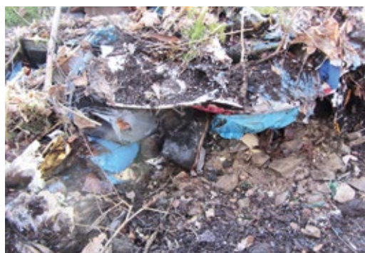
55. Müllablagerungen in Bunkerruinen sind keine Seltenheit und gefährden Menschen, Tiere und Umwelt. Die Kosten liegen je nach Größe der Ruine zwischen 500 und einigen 1000 €. Foto: MARKUS THIES
