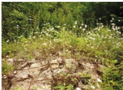
59. Typische Vegetation für Trockenstandorte auf einer Bunkerruine, hauptsächlich Margeriten ( Leucanthemum spec. ). Dieser Bereich wurde im Zuge des Pilotprojekts ganz freigestellt. (vgl. Abb. 60). Foto: BUND RLP
