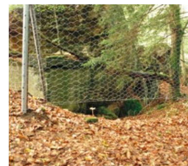
32. Im Zuge der ökologischen Baubegleitung überprüfte der BUND Zäune aus Sechseckgeflecht (Kaninchendraht) auf ihre Naturverträglichkeit. Das Material ist sehr kurzlebig, enthält aber keine Knoten (Todesfallen für Wildkatzen, Abb. 27) und der Zaun wurde mit ausreichend Bodenabstand gesetzt. Foto: BUND RLP
