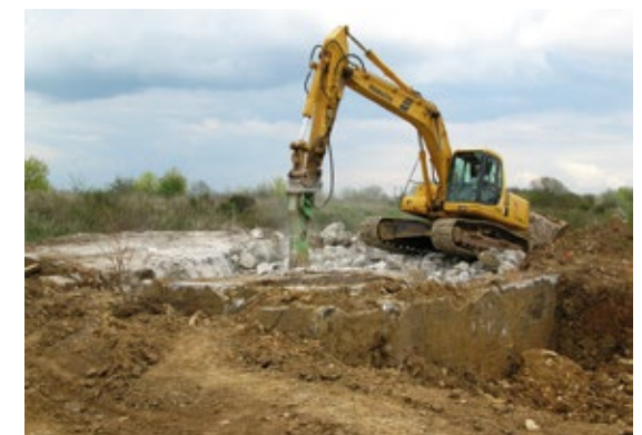
3. Zertrümmerung einer Bunkerruine. Foto: WALTER STUTTERICH
